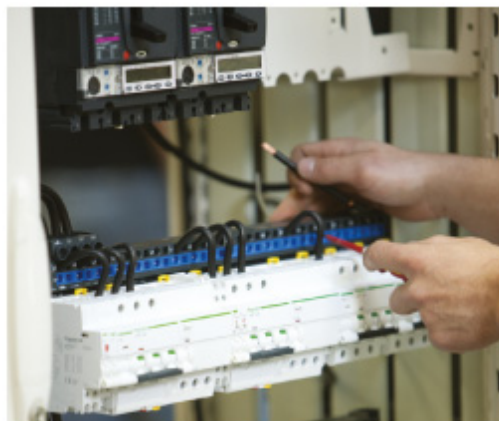
Fig. E30 – Montaje de un cuadro de distribución final con unidades funcionales fijas (Prisma G)
